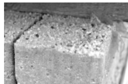
Fot. 1. Rozluźnienie warstwy płukanej
