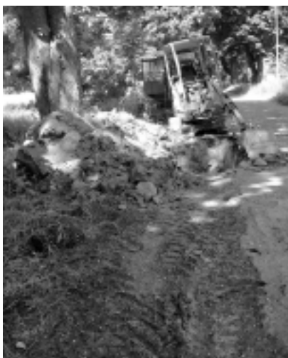
Prace ziemne mające na celu wykopanie rowu pod ułożenie instalacji. Na zdjęciu widoczne składowanie ziemi w rejonie systemów korzeniowych drzew
