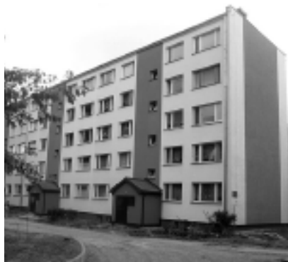
Fot. 4. Widok uzupełnienia zabudowy strefy wejściowej w niskim budynku prefabrykowanym
