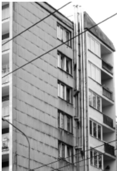
Fot. 3. Budynek wielorodzinny z wtórnice uzupełnionymi, prowadzonymi po elewacji, stalowymi przewodami spalinowymi
