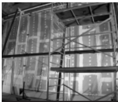
Fot. 1. Ściana w systemie suchej zabudowy o szerokości 10 m i wysokości 7 m do badania odporności ogniowej
