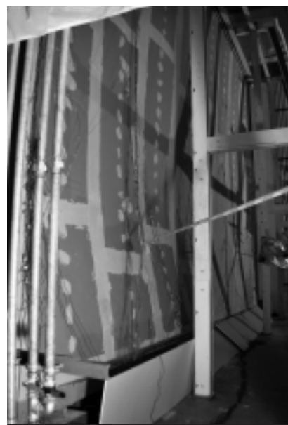
Fot. 2. Ściana w systemie suchej zabudowy podczas badania. W środku ściany widoczne wygięcie płyty g-k
