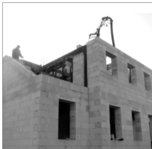
Zastosowanie rozwiązania systemowego przy wznoszeniu budynku ze ścianami z betonu komórkowego
