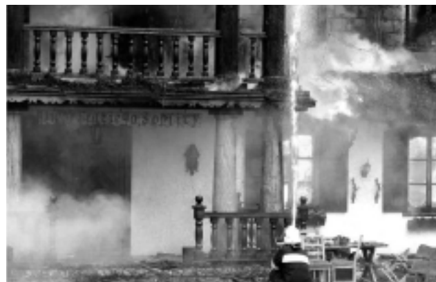
Pożar Dworu w Soplicowie; widoczne zniszczenie ocieplenia typu ETICS ściany zewnętrznej [Fot: K. Jankowski]
