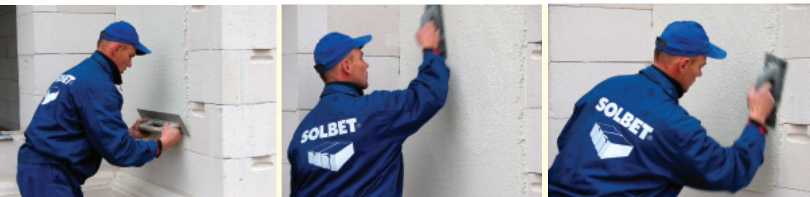
Nakładanie tynku SOLBET Terazyt S Baranek
