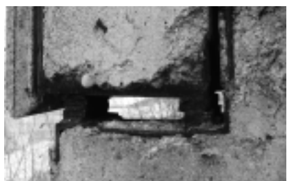
Fot. 2. Sposób oparcia ściany zewnętrznej podokiennej na ścianie poprzecznej w rzeczywistości Fot. M. Baszeń
