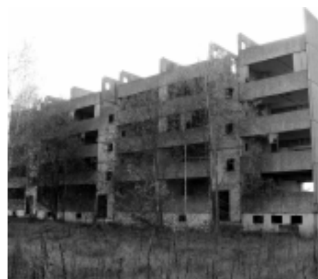
Fot. 1. Nieukończony budynek wielkopłytowy w systemie OWT-67N Fot. M. Baszeń
