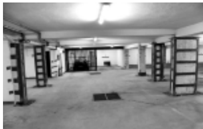
Fot. 3. Wzmocnienie słupów garażu podziemnego za pomocą kształtowników stalowych zrealizowane przez Freyssinet Polska w Warszawie w 2013 r.
