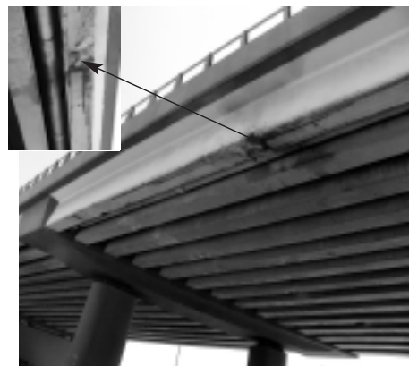
Fot. 1. Miejsce naprawy pierwszego uszkodzenia i zerwania wzmocniających taśm z włókna węglowego na pierwszej skrajnej belce
