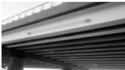
Fot. 2. Pręty sprężające Freyssibar zamontowane na uszkodzonych belkach skrajnych
