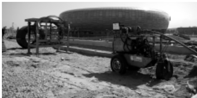
Urządzenie do wpuszczania stali sprężającej
