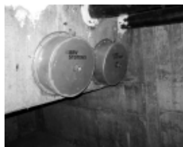
Zakotwienie kabli zewnętrznych BBV L19E
