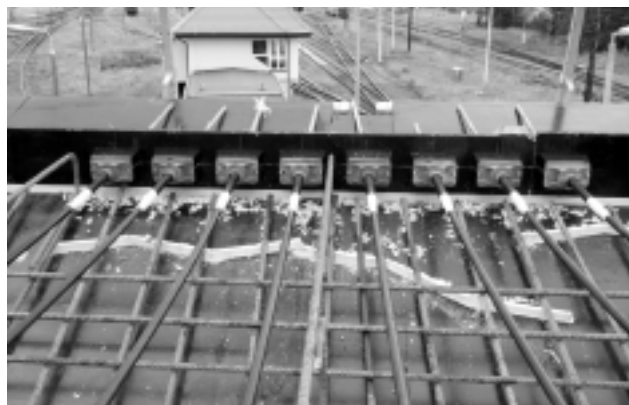
Zakotwienie kabli w indywidualnej osłonie antykorozyjnej BBV L01
