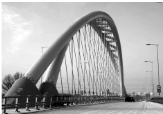
Fot. 1. Wiadukt WD-1
