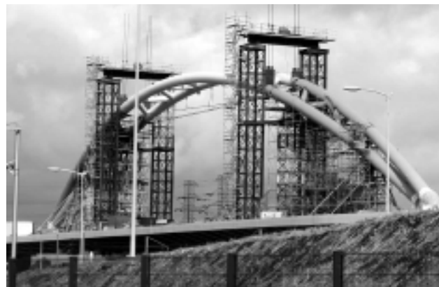
Fot. 3. Łuki stalowe wiaduktu WD-1
