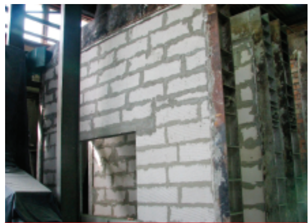
Fot. 4. Beton komórkowy wykorzystany w Zakładzie Badań Ogniowych ITB do budowy stanowisk badawczych
