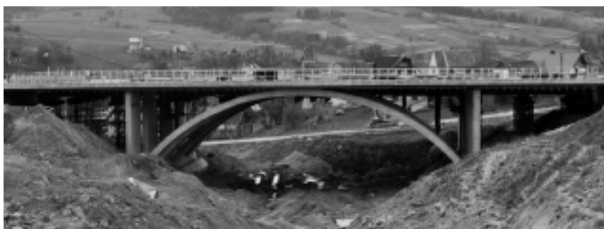
Fot. 2. Most łukowy z jazdą górą posadowiony na mikropalach
