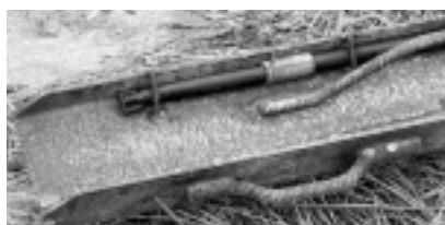
Fot. 1. Dolna część zbrojenia mikropala z rurkami iniekcyjnymi
