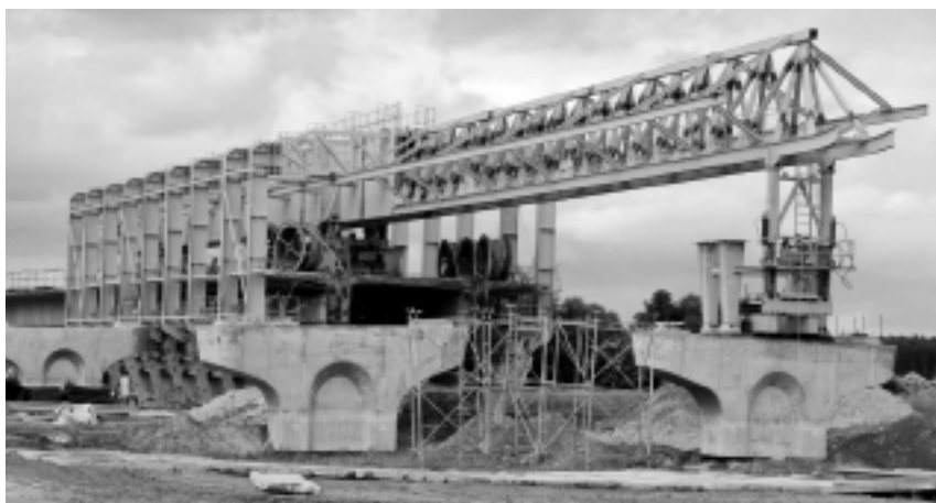
Fot. 4. Podpory estakady drogi ekspresowej posadowionej na mikropalach Fot. Autor
