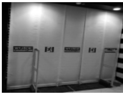
Kurtyna klasy ASB3 z rozdzielnych pasków ułatwiających ewakuację i ograniczających szybkie rozprzestrzenianie się dymów
