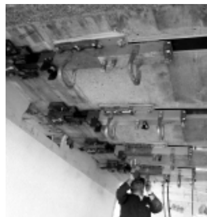
Fot. 3. Proces naciągu taśm CFRP podczas czynnego wzmocnienia
