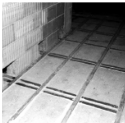
Fot. 1. Biernie wzmocnienie wieloprzęsłowej płyty żelbetowej
