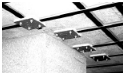
Fot. 2. Mechaniczne zakotwienie taśm CFRP, wzmocniających płytę stropową
