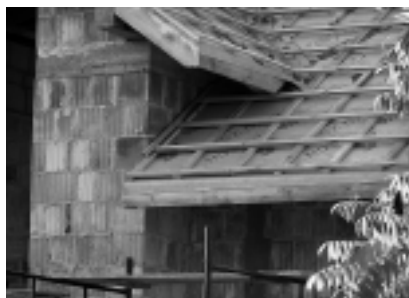
Fot. 13. Widoczna MWK będzie dociśnięta do deski pasem czołowym z blachy. Przekieki oraz skropliny zostaną zatrzymane za blachą. Deska czołowa jest zamocowana wg poziomicy, a za nią są końcówki krokwi na różnych poziomach
