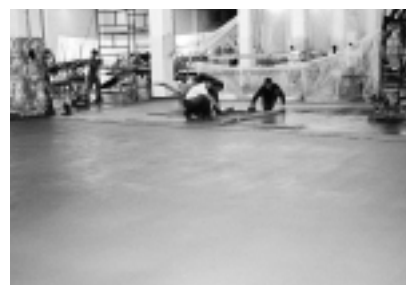
Fot. 4. Wymiana podłogi w pomieszczeniu chłodniczym
