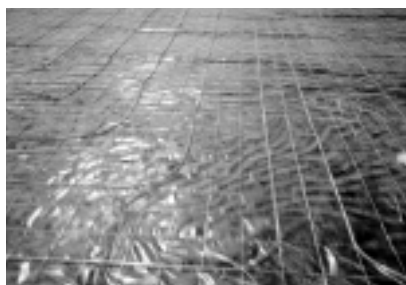
Fot. 2. Układanie instalacji grzewczej
