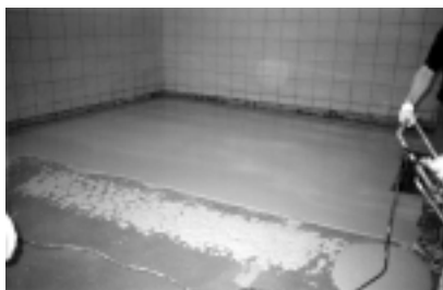
Fot. 3. Wymiana posadzki na istniejącym podkładzie betonowym
