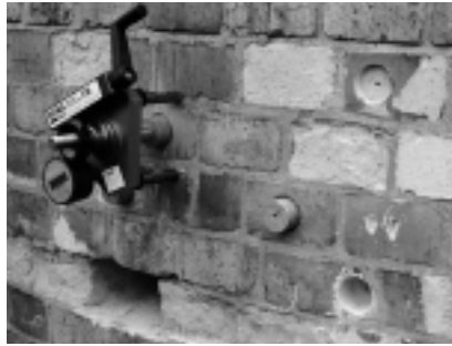
Fot. 2. Badania cegły in situ metodą pull-off Fot. Autor
