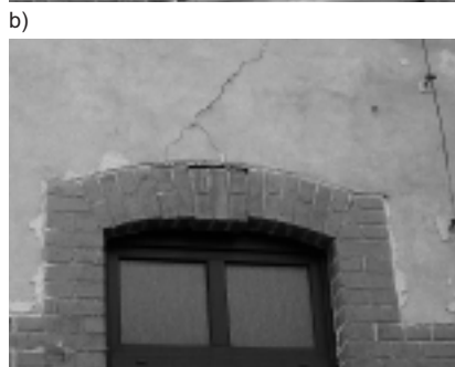
Fot. 1. Uszkodzenie nadproży łukowych w postaci spękań (a) i wypadania cegieł (b)
