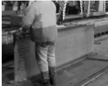
Fot. 1. Próbną montaż konstrukcji w Luksemburgu
