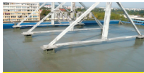
Fot. 2. W izolacji Kemperol® – nie ma połączeń!!
