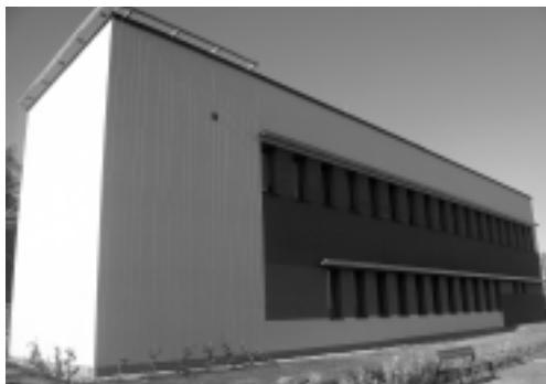
Fot. 3. Szkoła pasywna w Budzowie – widok od strony wschodniej w godzinach popołudniowych
