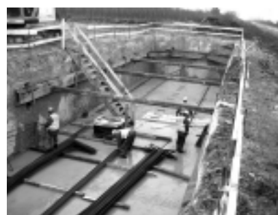
Fot. 6. Widok gotowej komory
