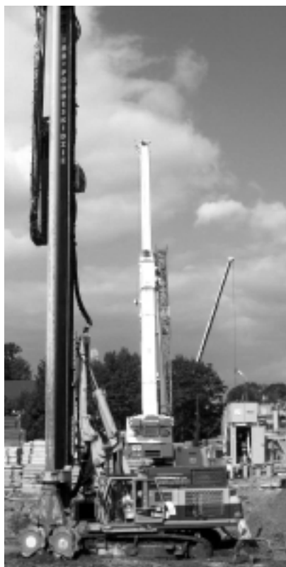
Fot. 1. Wiertnica RG 20 S wraz frezem
