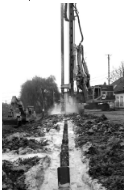
Fot. 4. Przesłona pionowa z kolumn CSM
