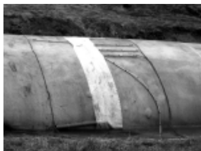
Fot. 2. System monitoringu płaszczu georury [Fot. archiwum Neo Strain Sp. z o.o.]
