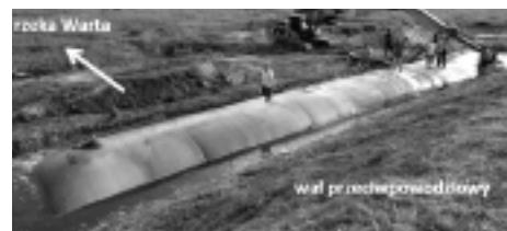
Fot. 1. Georura w podstawie wału rzeki Warty w Kole – ostatni etap pompowania pulpy [Fot. archiwum P.R. INORA sp. z o.o.]
