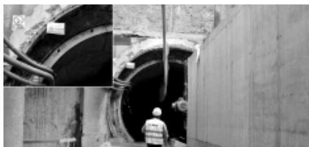
Fragment tunelu – widok od stacji Dworzec Wileński w stronę Wisły oraz zbliżenie na warstwę stwardniałej mieszanki wypełniająco-uszczelniającej między obudową tunelu i gruntem (lewy górny narożnik zdjęcia)
