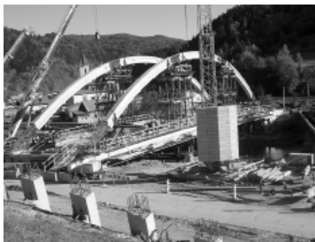
Fot. 3. Łukowy obiekt mostowy na rzece Poprad
