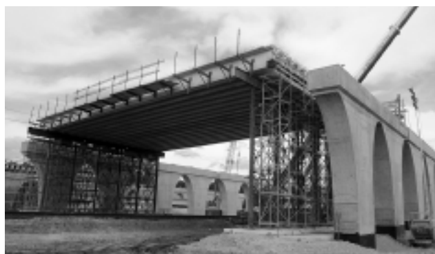
Fot. 1. Obiekt mostowy w ciągu A4
