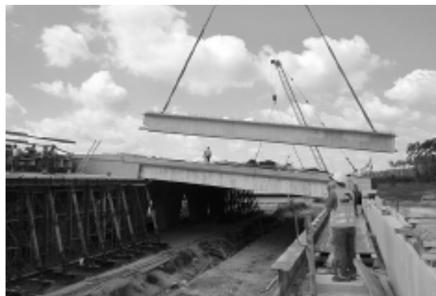
Fot. 2. Montaż elementów prefabrykowanych
