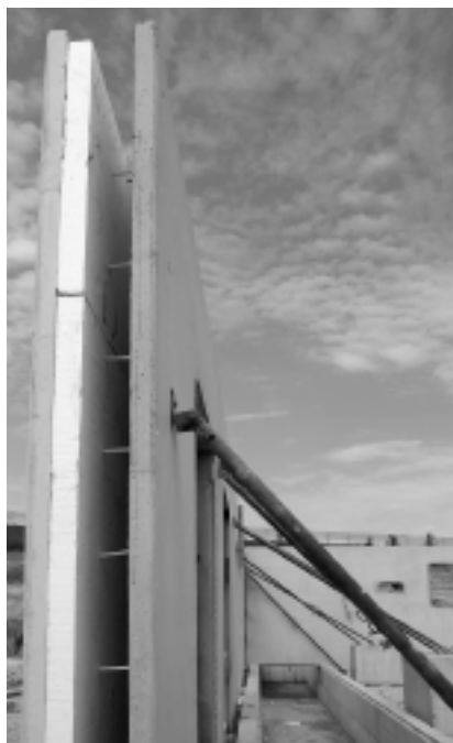
Kotwy termiczne ComBAR® Thermoanker zastosowane jako łączniki w ścianie warstwowej typu sandwich
