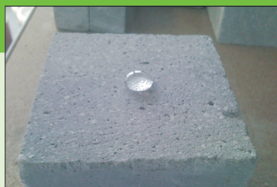
Powierzchnia betonowa zabezpieczona standardowym środkiem hydrofobizującym
