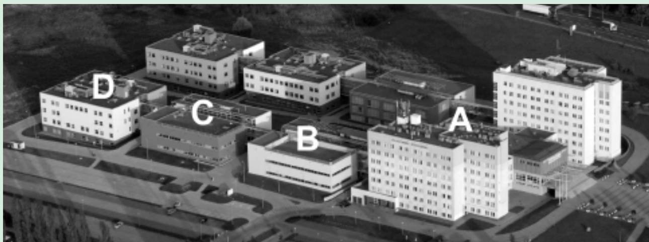
Fot. 3. Widok ogólny kampusu Politechniki Koszalińskiej przy ul. Śniadeckich: A – gmach główny Wydziału Inżynierii Lądowej, Środowiska i Geodezji; B – Laboratorium Techniki Budowlanej; C – Laboratorium Wytrzymałości Materiałów i Konstrukcji Budowlanych; D – Laboratorium Inżynierii Środowiska, Fotogrametrii i Teledetekcji
