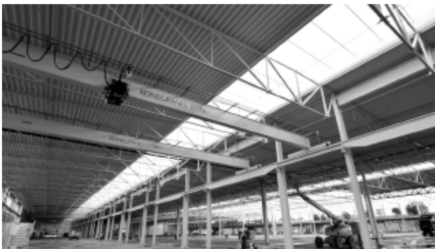
Budowa Europejskiego Centrum Stolarki firmy DRUTEX
