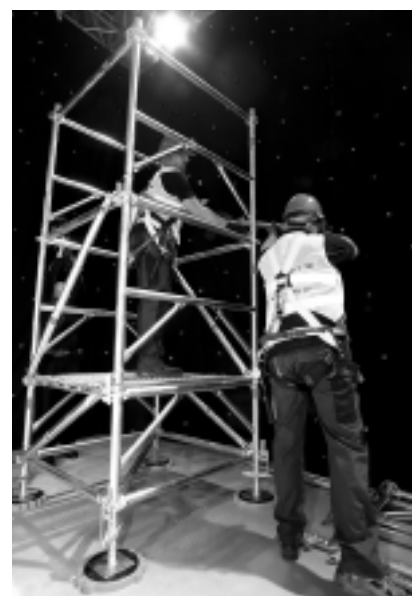
Montaż rusztowań systemu podporowego TG 60
