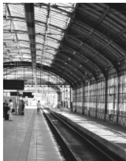
Stacja Wrocław Główny
