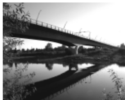
Obejście Północne Żywca. Most przez Solę
