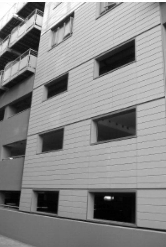
Fot. 5. Ceramiczna elewacja wentylowana – widok ogólny Fot. Marcin Karkocha
