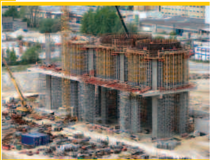
Widok na budynek sorbentu. Deskowanie belki pierścieniowej w systemie RUNDFLEX
