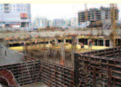
Zastosowanie systemu LOGO i systemu PAL20 na budowie Galerii Metro BIS
