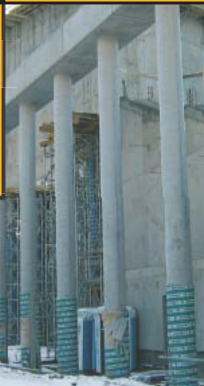
Rozwiązania dla betonu architektonicznego Opera i Filharmonia Podlaska, Białystok
