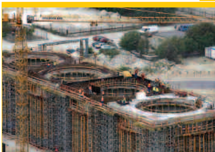
Widok z góry na budynek sorbentu
