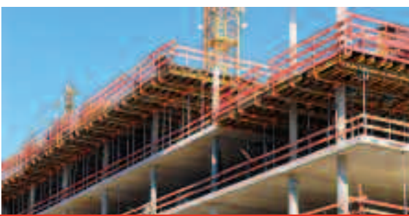
Fot. 6. Stoły stropowe VT z integralnymi poręczami zabezpieczającymi
