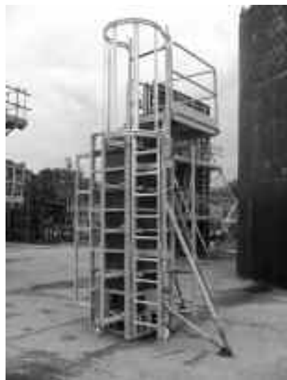
Fot. 1. Deskowanie pionowe F-4
