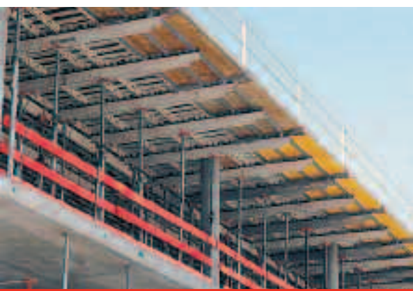
Fot. 7. Pomosty robocze SKYDECK zabezpieczające krawędź deskowanego stropu
