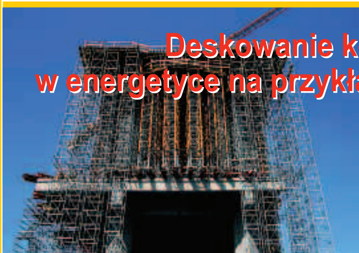
Deskowanie części wysokiej do poziomu +25,30 m
