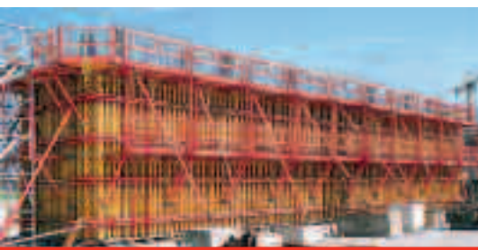
Fot. 1. Ścienne deskowanie dźwigarowe VARIO GT 24 z systemowymi pomostami roboczymi
