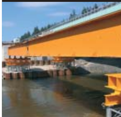
Blachownice do dużych obciążeń TAC 1200 Most na rzece Bóbr
