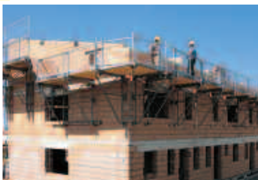
Fot. 8. Pomosty roboczo-zabezpieczające ASG 160
