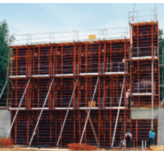
Fot. 2. Wielkowieściowa jednostka deskowania ramowego TRIO przemieszczana w całości razem z systemowymi pomostami roboczymi
