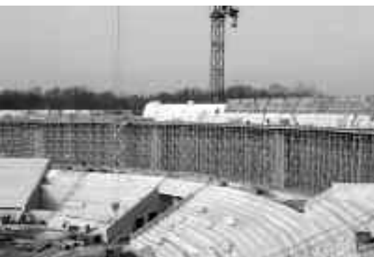
Budowa hali widowiskowo-sportowej w Łodzi
