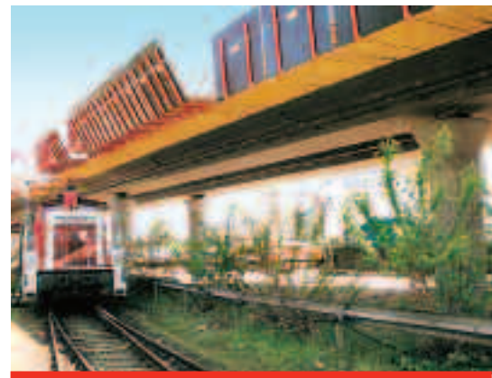
Fot. 10. Pomosty gzymsowe GKB z osłoną przeciwporażeniową
