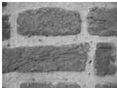
Fot. 1. Zaprawa wapienna pełni rolę poduszki i otuliny, dobrze chroniąc cegły przed zniszczeniem
