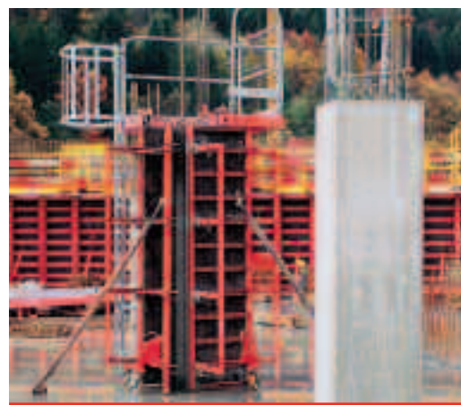
Fot. 4. Deskowanie słupów QUATTRO z drabiną i platformą betoniarską
