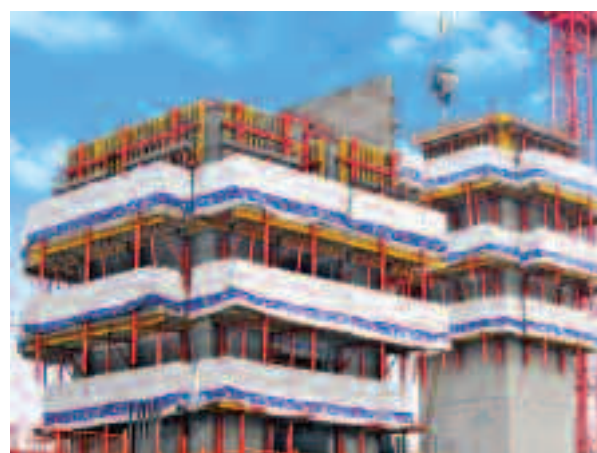
Fot. 13. Pomosty robocze RCS C
