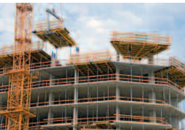
Fot. 5. Wielkowymiarowe stoły stropowe UNIPORTAL z integralnymi poręczami zabezpieczającymi
