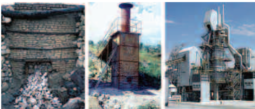
Fot. 1. Rozwój technologii wypalania wapna, od lewej: tradycyjny piec komorowy ( www.howtopedia.org ), prymitywny piec szybowy ( ibid. ), nowoczesny piec wapienniczy opalany gazem ( www.graymont.com )
