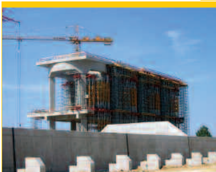
Rozdeskowanie pierwszej belki pierścieniowej oraz stropu w poziomie +25,30 m
