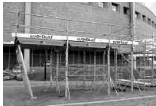
Fot. 3. Deskowanie panelowe CC-4
