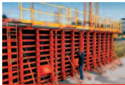
Fot. 3. Wielkowieściowe deskowanie ramowe TRIO Housing z jednostronnymi ściągami
