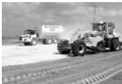
Stabilizacja wapnem palonym na budowie autostrady A4
