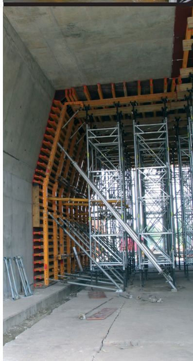
◀ Tunel „Hulanka” w Bielsku-Białej Deskowanie dźwigarkowe DSD 12/20, wieże T60
