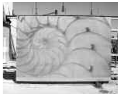
Fot. 4. Prefabrykat ścienny z betonu graficznego [Materiały International Seminar „Prefabrication in Europe”, Politechnika Krakowska, 2007]
