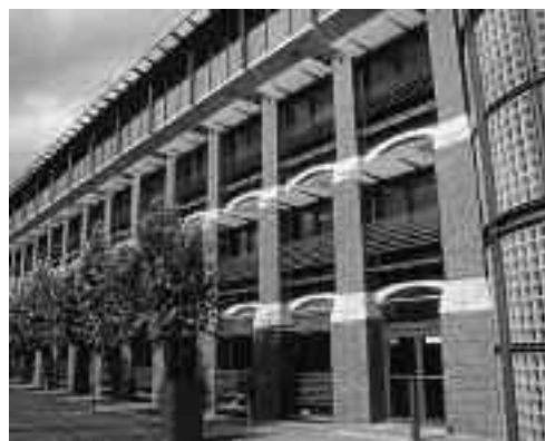
Fot. 5. Prefabrykaty słupowe murowane z cegły [Materiały International Seminar „Prefabrication in Europe”, Politechnika Krakowska, 2007]
