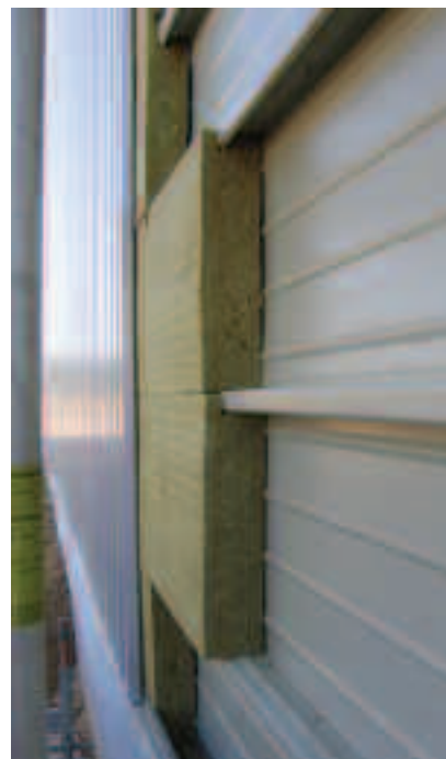
Fot. 1. Stalrock MAX – płyta ze skalnej wełny mineralnej do izolacji ściennych obudów hal z kaset wzdłużnych
