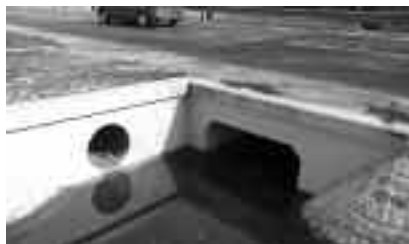
Fot. 4. Widok wyremontowanego przepustu uniemożliwiającego migrację zwierząt Fot. A. Wysokowski
