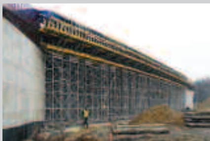
Podparcie i deskowanie ustroju nośnego
