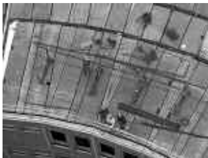
Fot. 1. Oparcie płyt stropowych na ścianach nośnych [ Materials International Seminar „Prefabrication in Europe” , Politechnika Krakowska, 2007]
