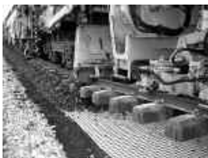
Przykład wzmacniania nasypu kolejowego za pomocą geokompozytu
