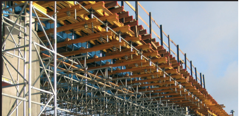
▲ Most w Morgownikach ▶ Deskowanie dźwigarkowe DSD 12/20, wieże T60, rusztowanie DORPA
