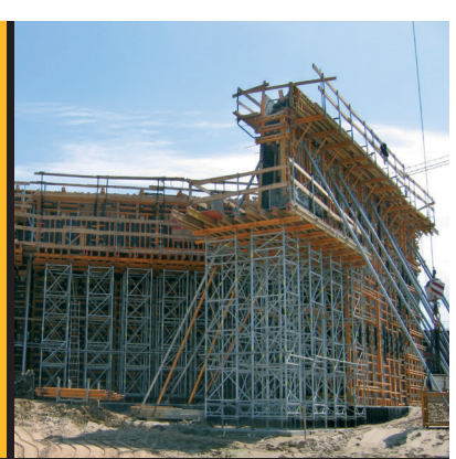
Autostrada A1, obiekt WA 76 ▶ Wieże T60, deskowanie ramowe ORMA
