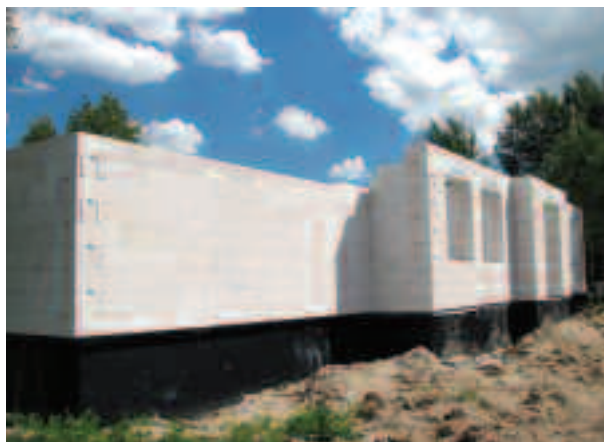
Nowo budowany budynek w systemie Solbet
