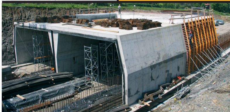
◀ Tunel „Hulanka” w Bielsku-Białej Deskowanie dźwigarkowe DSD 12/20, wieże T60
