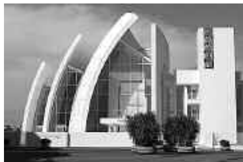
Fot. 6. Prefabrykowana konstrukcja kościoła Dio Padre Misericordioso w Rzymie [Materiały International Seminar „Prefabrication in Europe”, Politechnika Krakowska, 2007]
