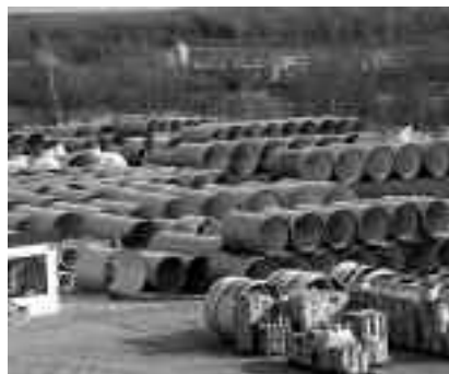
Fot. 3. Powłoki z żywicy poliestrowych wzmocnionych włóknem szklanym (CC GRP) wykorzystywane w konstrukcjach gruntowo-powłokowych
