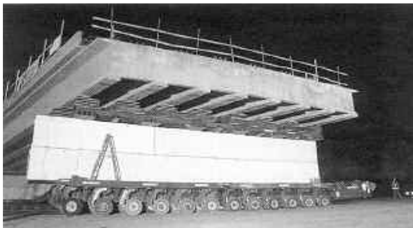
Fot. 3. Wieloosiowy pojazd z kontrolowanym komputerowo rozkładem obciążenia na ós przewożący całe przęsło mostowe [Federal Highway Administration, Lifting the Graves Avenue Bridge to Success . Washington, DC. 2006]
