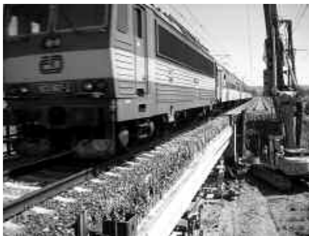
Zabezpieczony nasyp z tłucznia pod torami
