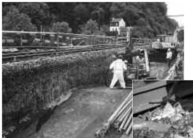
Nakładanie środka żywicznego MC-Balastbond 70
