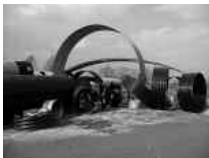
Fot. 2. Powłoki ze stalowych blach karbowanych wykorzystywane w konstrukcjach gruntowo-powłokowych
