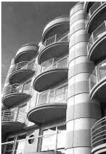
Fot. 3. Przykłady elewacji z betonu architektonicznego [Materiały International Seminar „Prefabrication in Europe”, Politechnika Krakowska, 2007]
