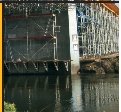
▲ Most w Morgownikach ▶ Deskowanie dźwigarkowe DSD 12/20, wieże T60, rusztowanie DORPA
