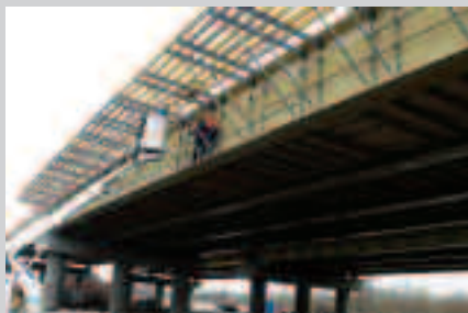
Deskowanie ustroju nośnego
