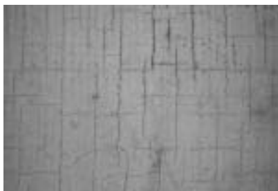
Fot. 3. Zbrojenie jako ostatnia warstwa
