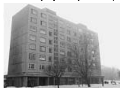
Fot. 1. Budynek mieszkalny w Dunaújváros przed modernizacją (źródło: www.solanova.eu)
