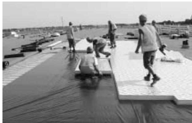
Układanie płyt EcoTherm na dachu fabryki Hyundai w Czechach
