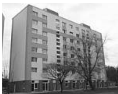
Fot. 2. Budynek mieszkalny w Dunaújváros po modernizacji (źródło: www.solanova.eu)
