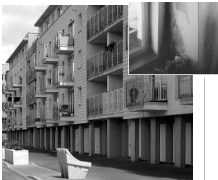
Fot. 2. Parter budynku oparto na nieocieplonych słupach żelbetowych, co było przyczyną powstania pleśni w mieszkaniach nad słupami
