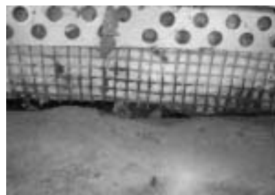
Fot. 9. Obrobienie cokołu
