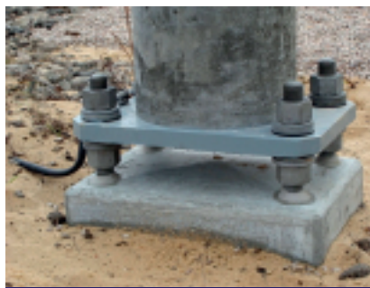
Fot. 4. Połączenie słupa ETG z pałem fundamentowym
