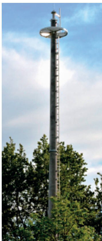
Fot. 5. Dwusegmentowa wieża o wysokości 25 m n.p.t. w trakcie montażu
