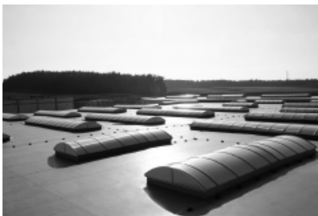
Dach o powierzchni 12 tys. m 2 obiektu StopShop w Kętrzynie pokryty membraną Monarplan® FM
