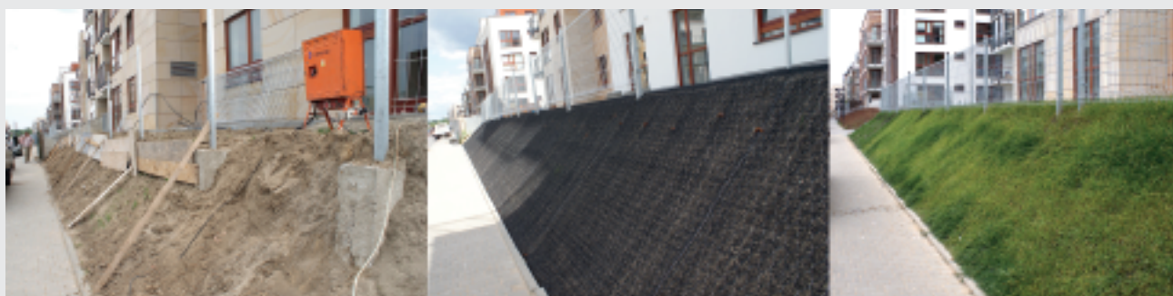
Zabezpieczenie powierzchniowe skarpy na osiedlu Wilanów w Warszawie
