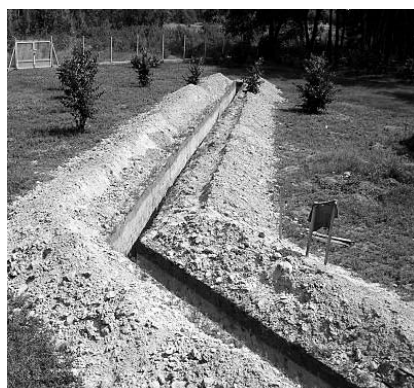
Wykonanie wykopu na potrzeby rurowego wymiennika ciepła (fot. S. Firląg)
