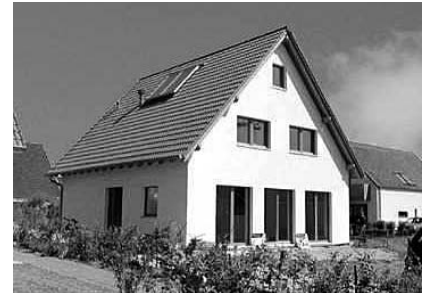
Fot. 2. Budynek pasywny w Munster (źródło: www.europassivhaus.de)
