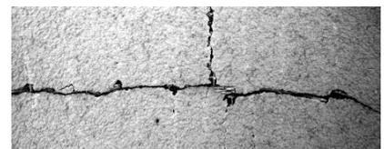
Fot. 3. Widok zarysowań na elewacji, siatka zbrojąca znajduje się pod wyprawą tynkarską
