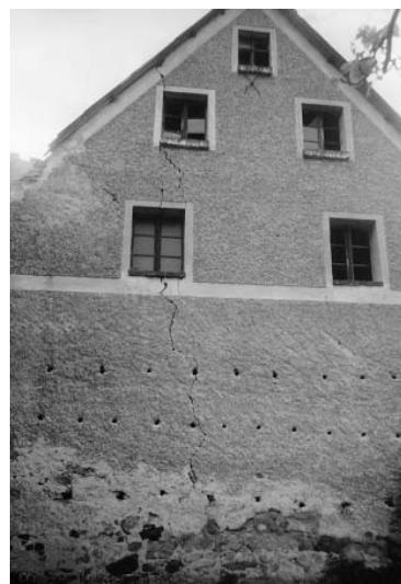
Fot. 1. Przykładowy widok budynku murowanego z nawierconymi otworami zwiększającymi powierzchnię odparowania wilgoci
