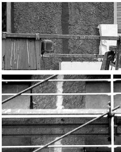
Fot. 1. Prawidłowo przygotowane podłoże
