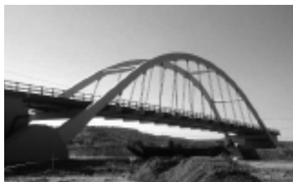
Fot. 1. Widok ogólny mostu
