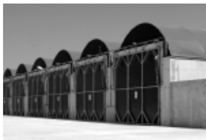
Fot. 1. Reaktory stabilizacji tlenowej, widok zewnętrzny
