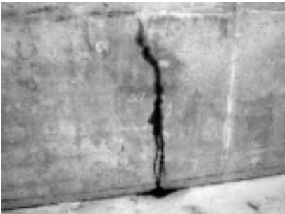
Fot. 2. Miejsce zarysowania skurczowego oraz przecieku wody deszczowej przez ścianę komory reaktora stabilizacji tlenowej Photo 2. The place of the shrinkage crack and rainwater leakage through the chamber wall of the aerobic stabilization reactor
