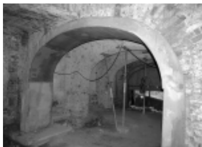
Fot. 3. Żelbetowy łuk podpierający w piwnicy Photo 3. Reinforced concrete supporting arch in basement
