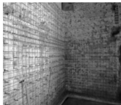
Fot. 4. Zbrojenie żelbetowej koszulki wzmacniającej ściany Photo 4. Reinforcement of concrete strengthening wall
