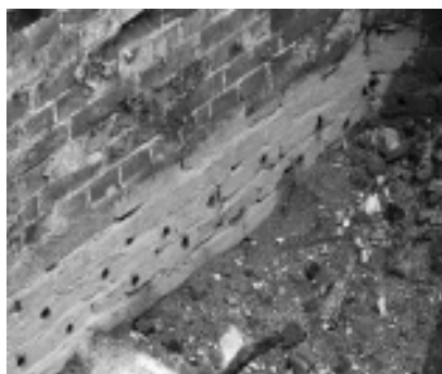
Fot. 2. Izolacja iniekcyjna fundamentów Photo 2. Injection insulation of foundations
