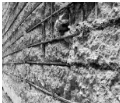
Fot. 4. Przygotowanie podłoża Photo 4. Substrate preparation
