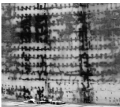
Fot. 5. Reprofilacja ubytków płaszczu Photo 5. Filling of the concrete losses in the inner shell
