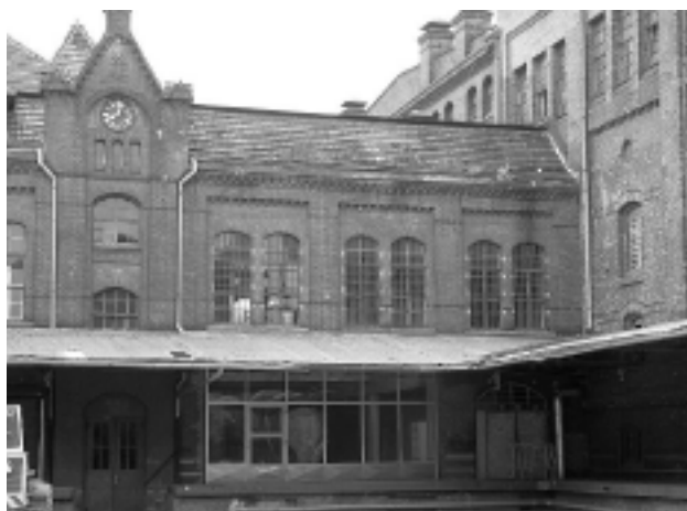
Fot. 2. Widok ogólny budynku „butelkowni”
