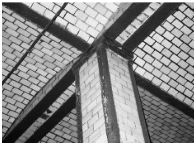
Fot. 3. Szczegół stropu odcinkowego na parterze budynku „butelkowni”
