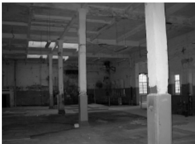
Fot. 4. Strop Kleina na szkieletie stalowym w budynku „leżakowni”
