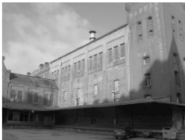
Fot. 1. Widok ogólny budynku „leżakowni”
