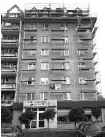
Fot. 1. Rusztowanie wykorzystywane do prac przy obróbkach blacharskich w Lublinie, 2013
