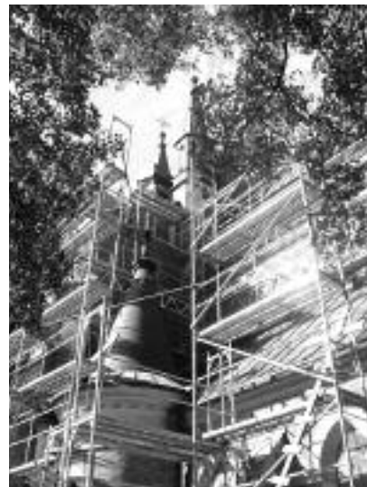
Fot. 3. Rusztowanie wykorzystywane do prac konserwatorskich w Wąwolnicy, 2011
